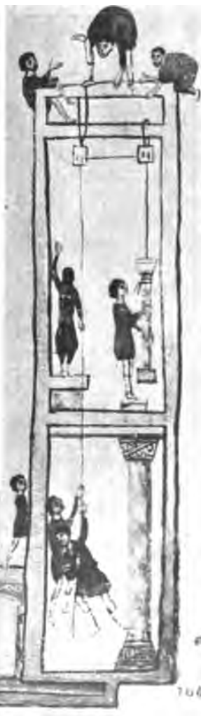
Fig. 179. — Construction d'un édifice. Miniature du Psautier Barberini (Bibl. Vaticane). Manuel d'Art byzantin.
